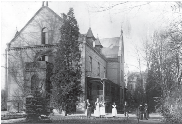
387 Haus der Gräfin-Rittberg-Schwestern, Kaiserstraße 67, Giebelansicht, 1911
